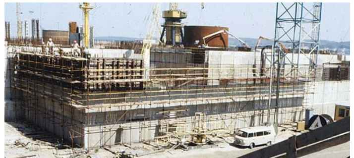
Tak wyglądały początki niezrealizowanej inwestycji: elektrowni jądrowej w Żarnówcu. Fot. z archiwum Autora.
